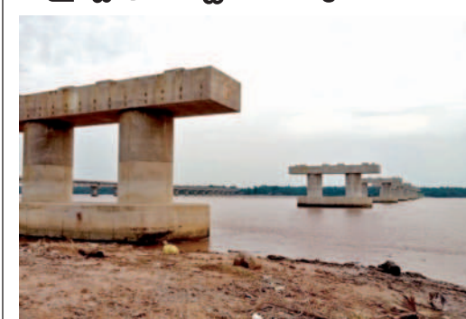
నిర్మాణం మధ్యలో నిలిచిపోయిన రైల్వే బ్రిడ్జి వసులు
